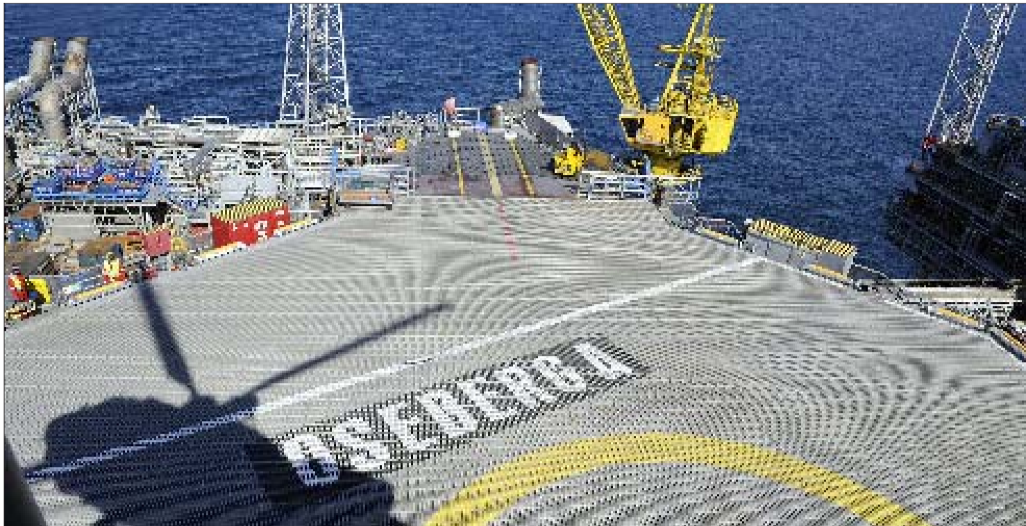
TRE INSTALLASJONER: Oseberg Feltsenter består av tre plattformer: Oseberg A, B og D. Etter ulykken torsdag er det flydd ut et kriseteam til senteret. (Foto: Harald Pettersen/StatoilHydro)
